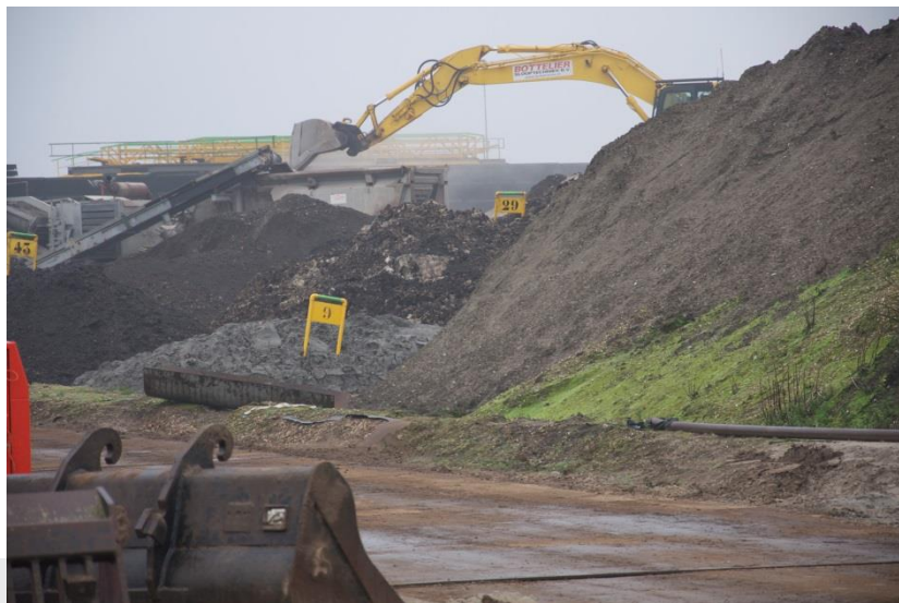
Foto: Risico op energieoverslag.
